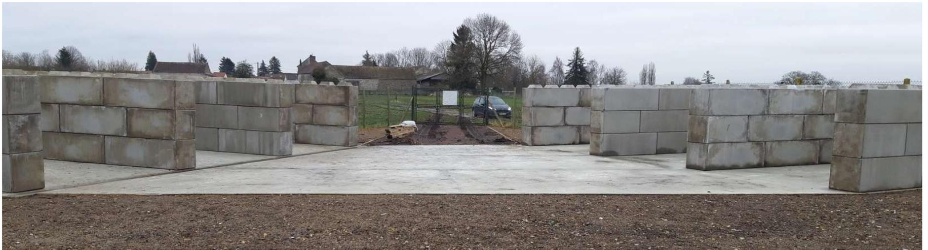
Cloisons installées, 6 caissons permettront de stocker les matériaux.
